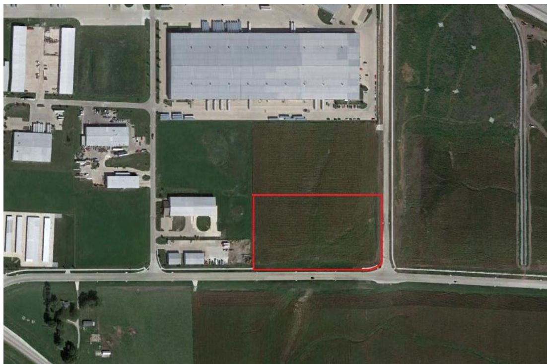
Figura 22. Vista aérea del terreno escogido para la implantación de la planta de tratamiento.
