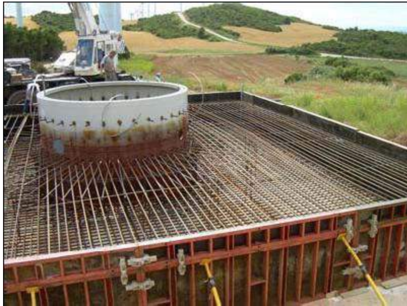
Figura 3.11 Detalle de la cimentación. Fuente: Documentación Javier Sanchís, EOI
