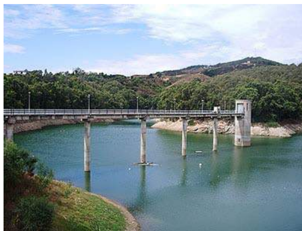
Figura 4.14 Imagen de la Presa del Renegado. Fuente: Confederación Hidrográfica del Guadalquivir
