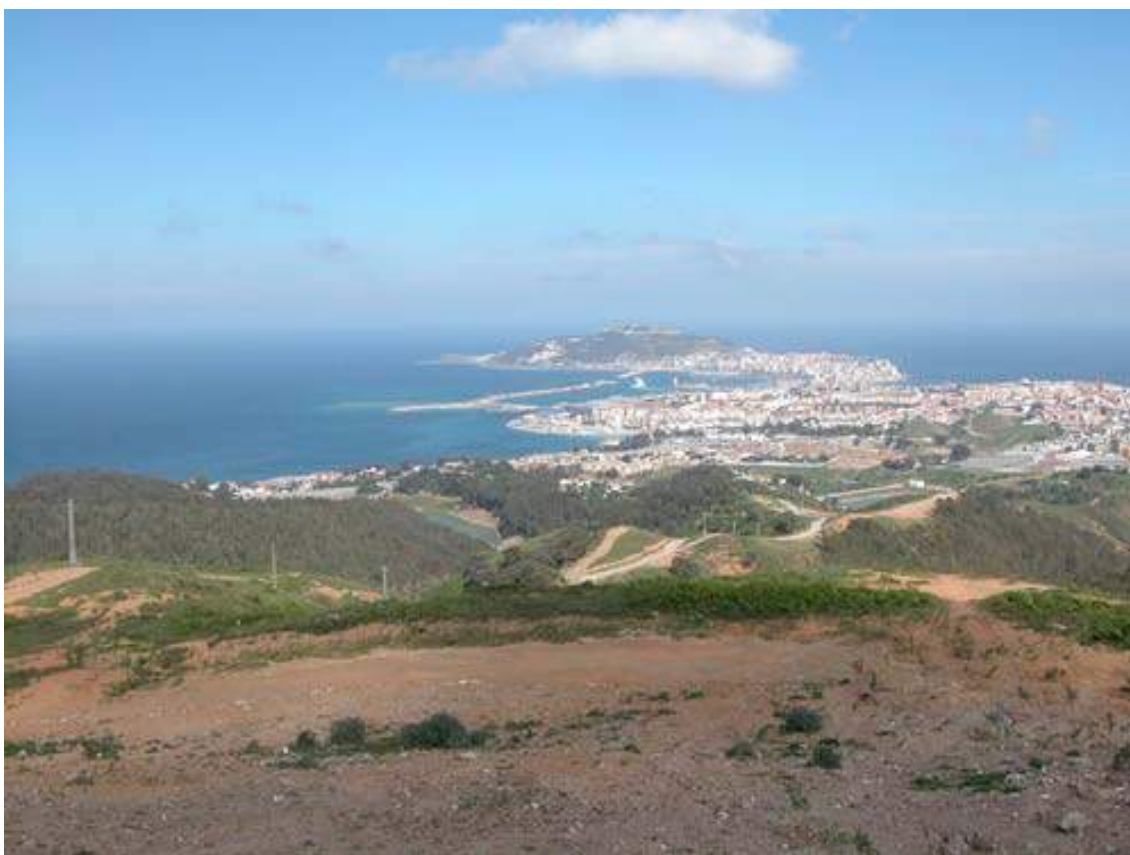
Ilustración 7. Zona de construcción del parque eólico
