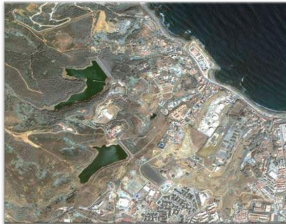
Figura 4.13 Vista aérea de los embalses del Renegado e Infierno. Fuente: Confederación Hidrográfica del Guadalquivir
