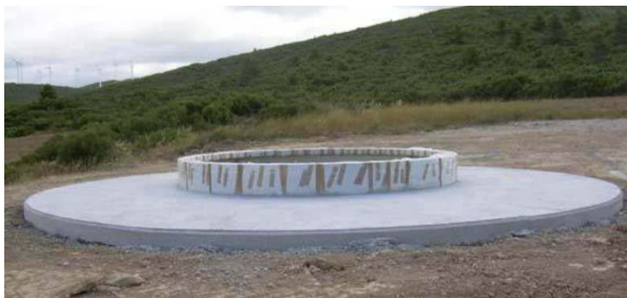
Figura 3.12 Estado final de la cimentación. Fuente: Documentación Javier Sanchís, EOI
