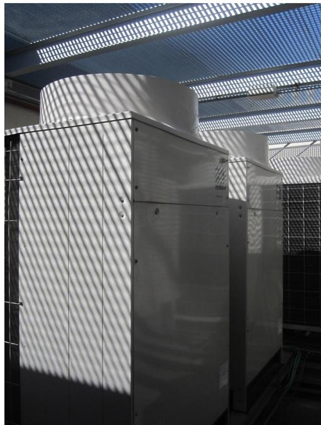
Figura 5.21: Detalle de las unidades exteriores VRF
