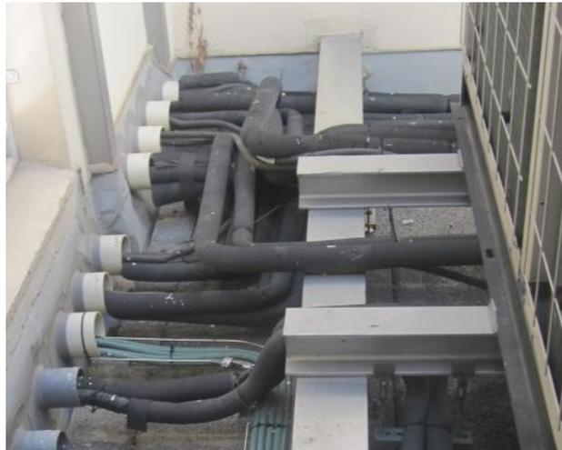
**Figura 5.10: Detalle del aislamiento**
