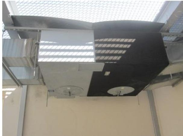
Figura 5.12: Detalle del recuperador entálpico
