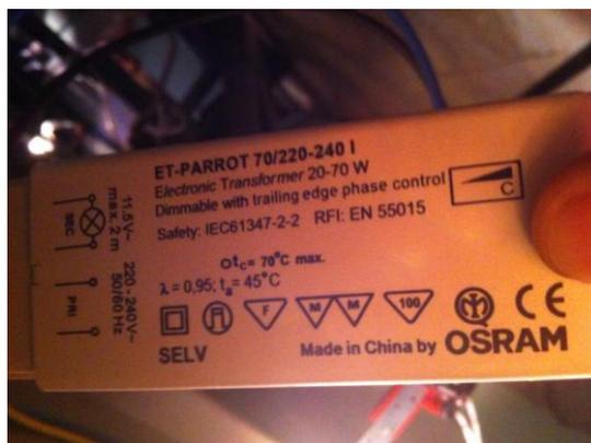
Figura 5.42: Detalle de balasto electrónico
