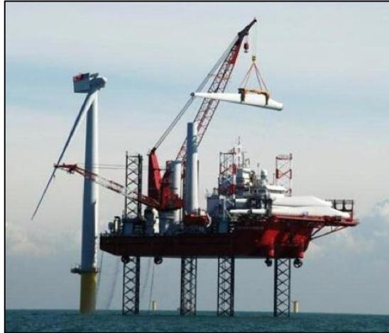
Figura 118. Instalación de las palas sobre el buje
