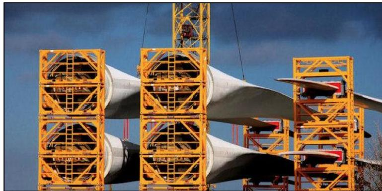
Figura 101. Estructura en celosía para elevación de palas
