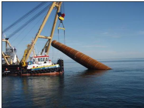
Figura 107. Izado de pilote mediante el upending
