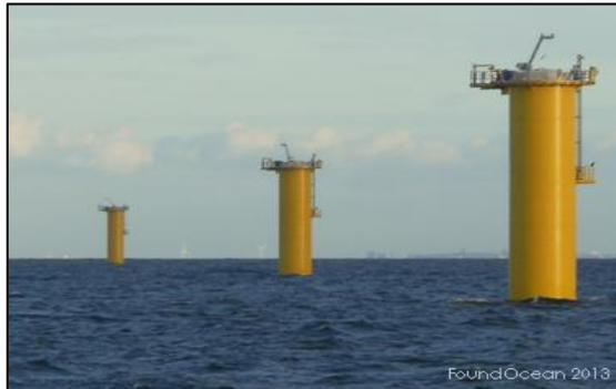
Figura 114. Pieza de transición instalada
