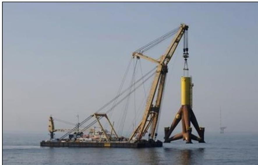
Figura 81: Instalación de un trípode
