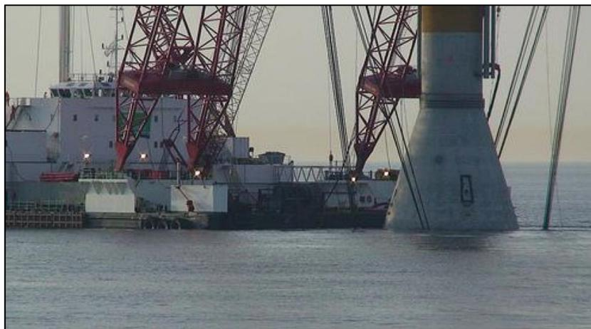
Figura 85: Instalación de cimentación por gravedad
