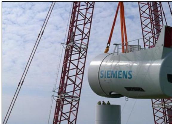
Figura 117. Instalación del buje y la nacelle sobre la torre
