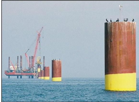
Figura 111. Mono pilotes instalados
