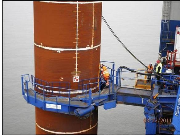
Figura 108. Colocación del gripper alrededor del mono pilote
