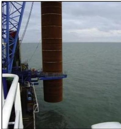
Figura 109. Colocación vertical del pilote previo al stabbing
