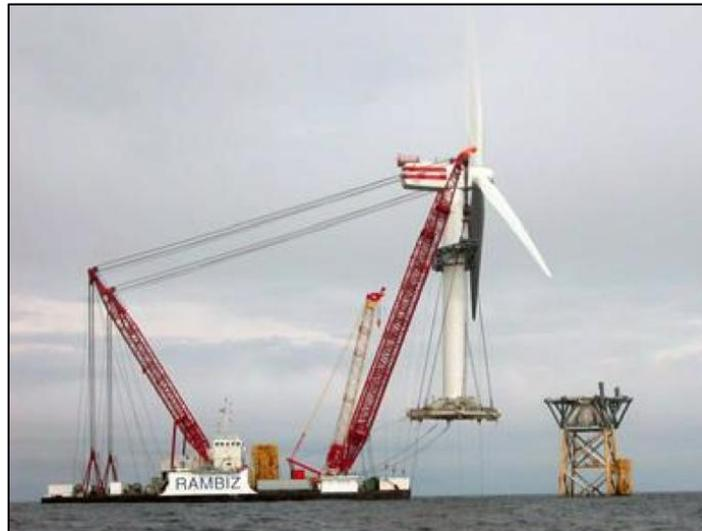
Figura 83: Instalación de Jacket
