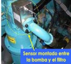
Sensor montado entre la bomba y el filtro
