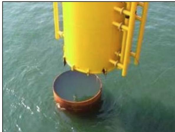
Figura 113. Colocación de la pieza de transición sobre el mono pilote
