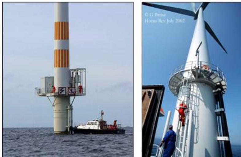
Figura 128 (a y b). Acceso al aerogenerador por vía marítima.
