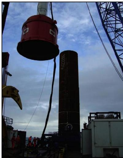
Figura 110: Colocación del martillo hidráulico
