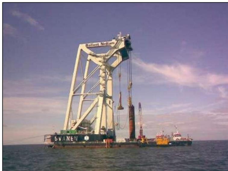
Figura 79: Instalación de un mono pilote
