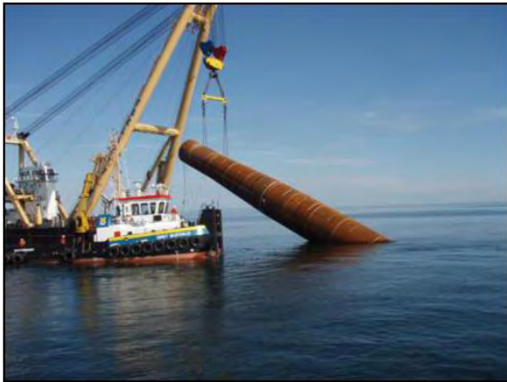
Figura 110. Izado de pilote mediante el upending
