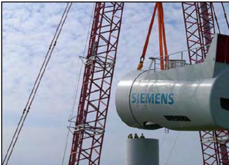
Figura 120. Instalación del buje y la nacelle sobre la torre
