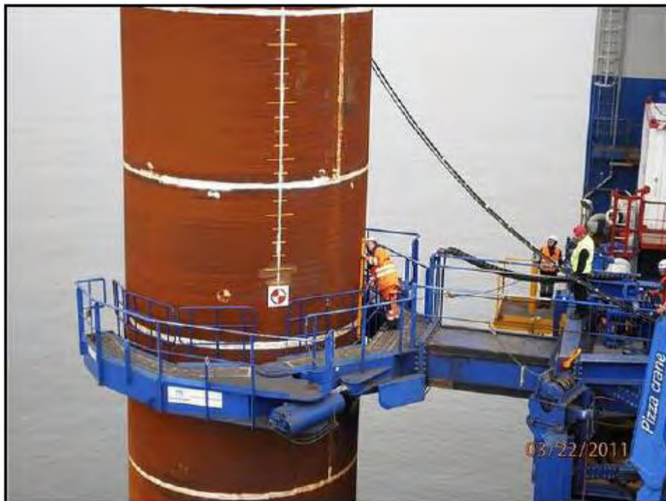
Figura 111. Colocación del gripper alrededor del monopilote
