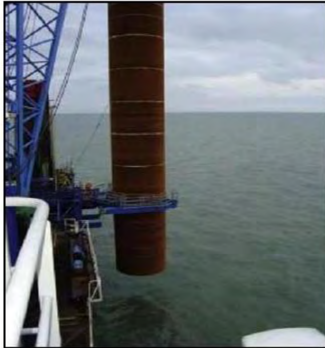
Figura 112. Colocación vertical del pilote previo al stabbing
