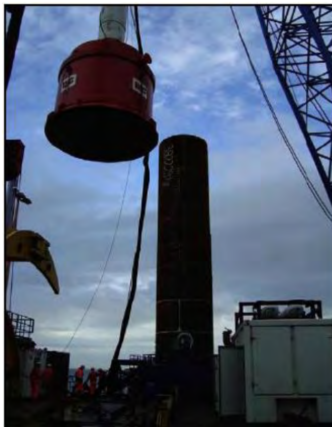
Figura 113. Colocación del martillo hidráulico
