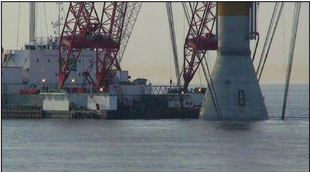
Figura 79. Instalación de cimentación por gravedad
