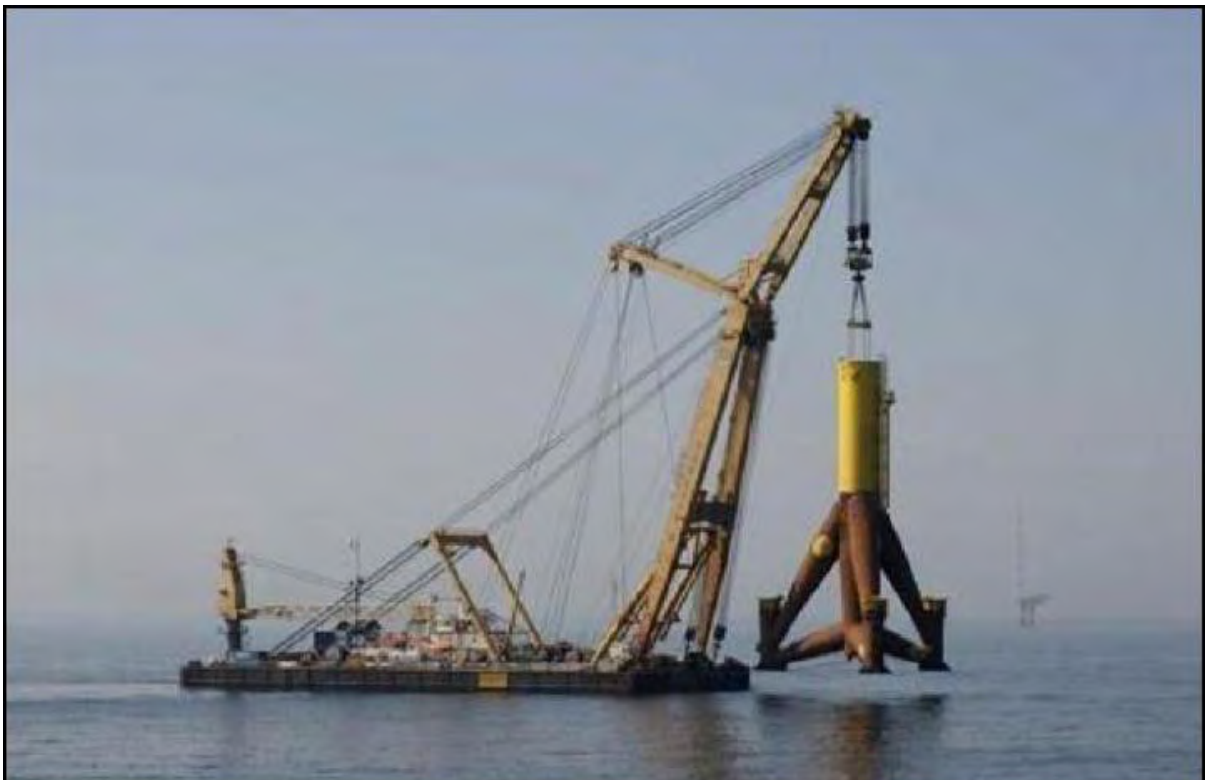
Figura 75. Instalación de un trípode
