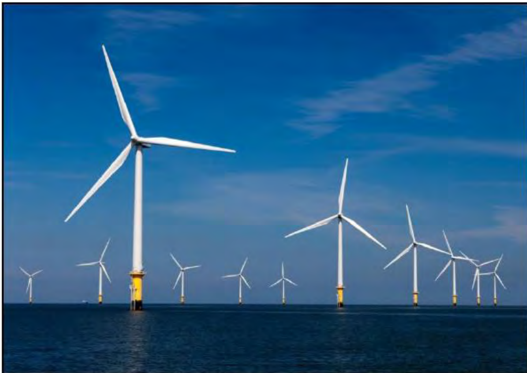
Figura 122. Aspecto final de las turbinas
