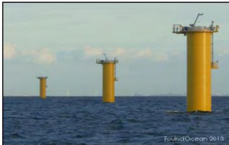
Figura 117. Pieza de transición instalada
