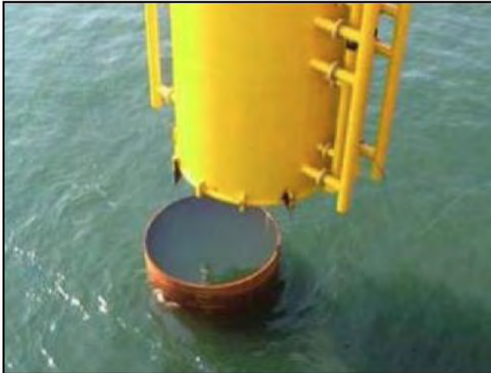
Figura 116. Colocación de la pieza de transición sobre el monopilote
