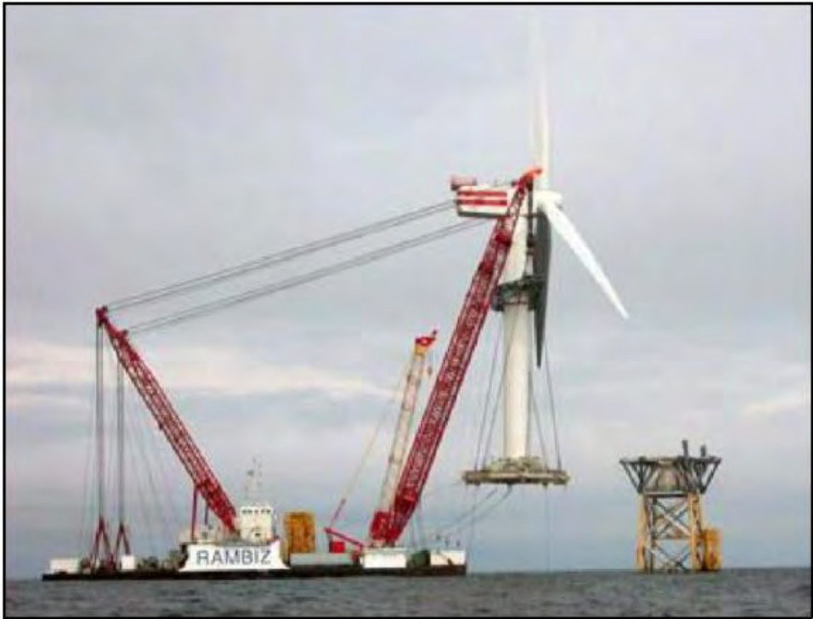
Figura 77. Instalación de Jacket
