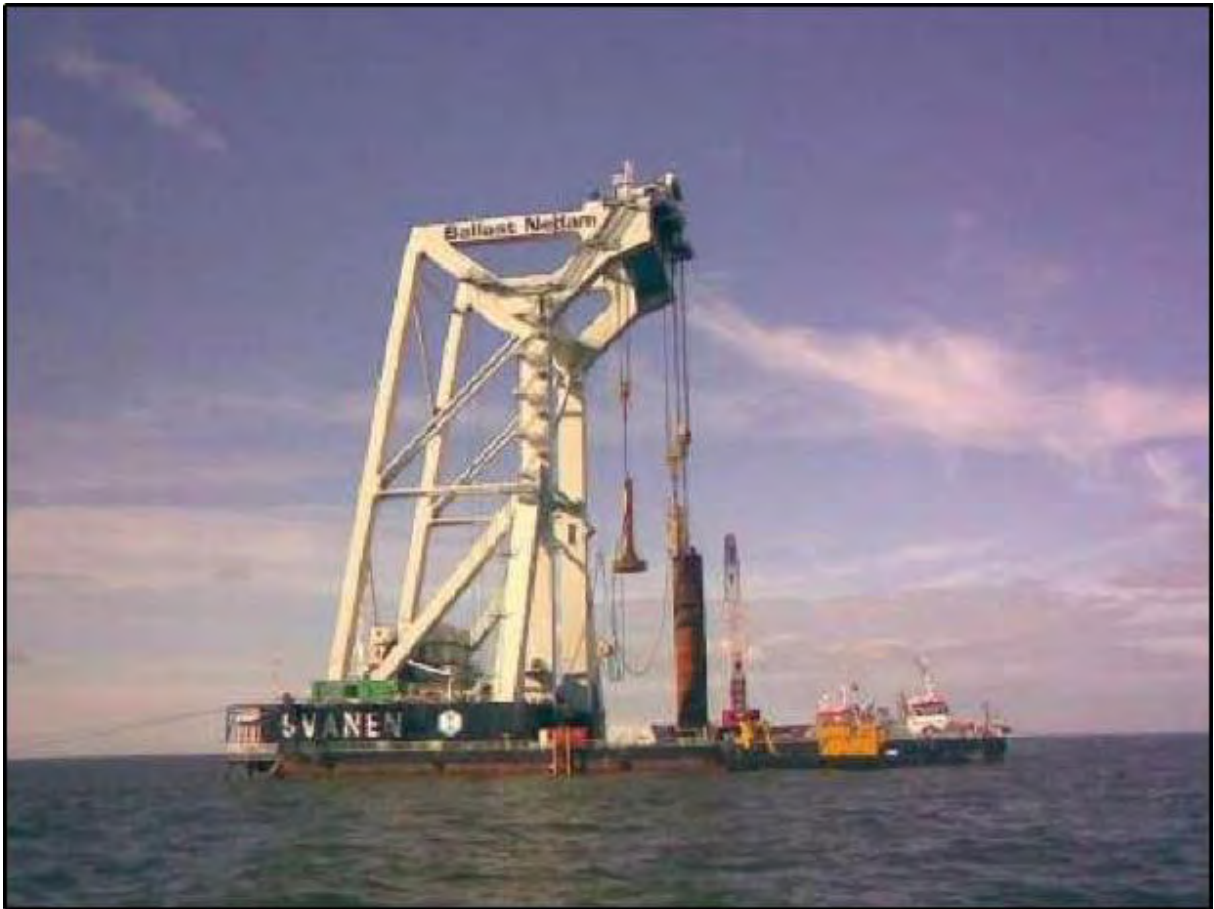
Figura 73. Instalación de un monopilote
