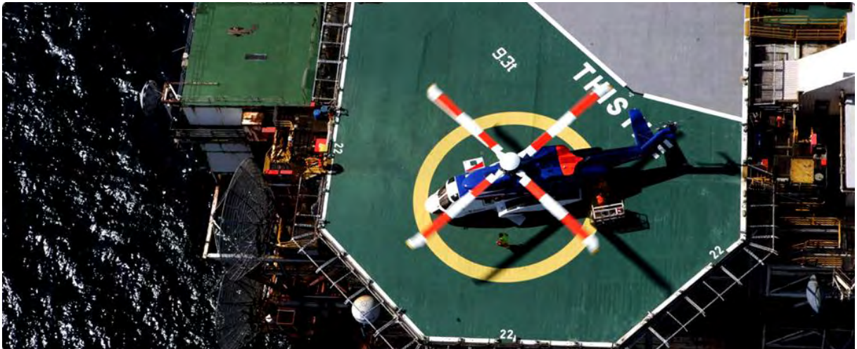
Figura 91. Helipad de subestación offshore (Fuente: Heliport lighting)
