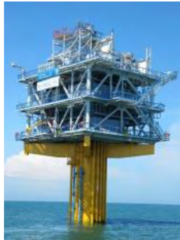
Figura 90. Subestación offshore (Fuente: 4COffshore).
