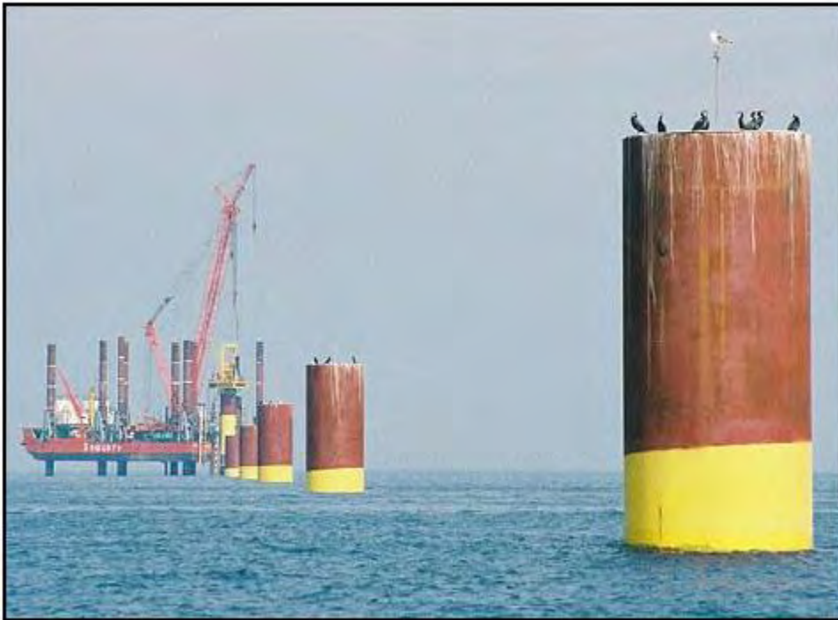
Figura 114. Monopilotes instalados
