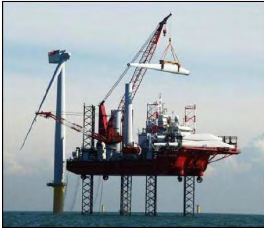
Figura 121. Instalación de las palas sobre el buje
