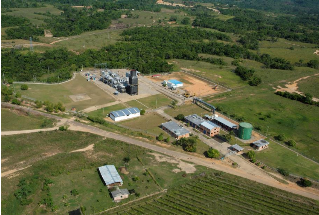
Figura 1. Instalaciones Central Meriléctrica
