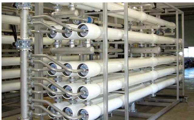
Figura 13: Detalle bastidor de membranas
