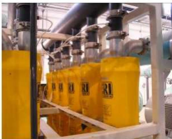
Figura 47: Detalle Sistema de Recuperación de Energía
