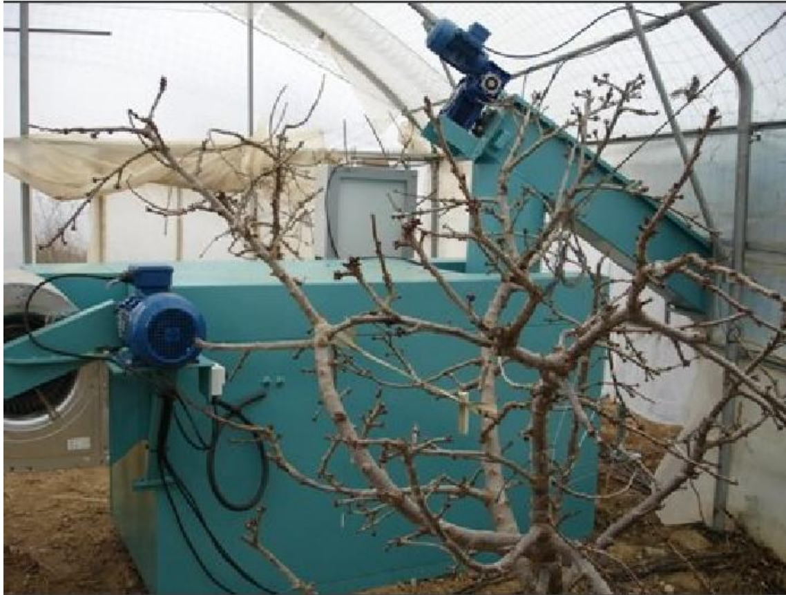
Figura 7. Instalación de caldera de biomasa invernadero
