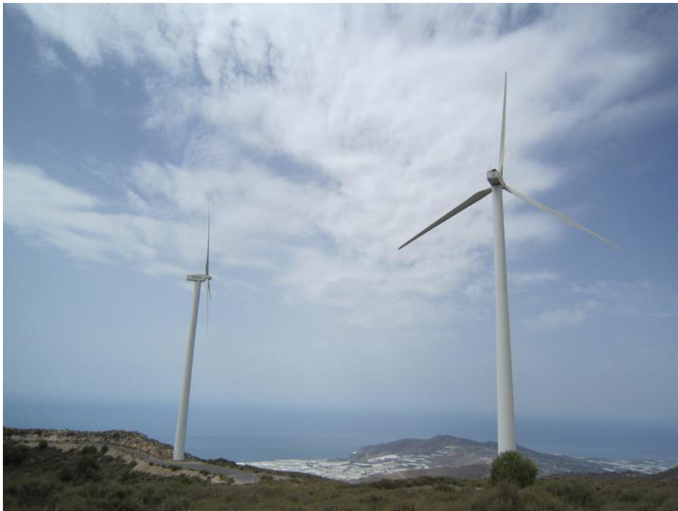
Figura 11. Visita zona invernaderos y parque eólico
