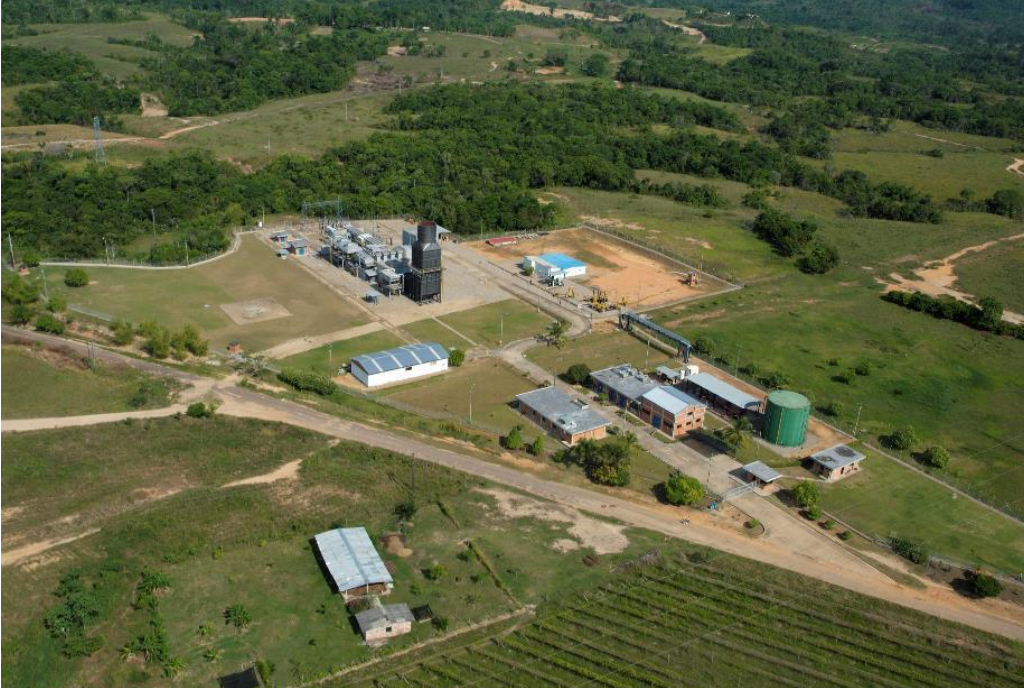
Figura 1. Instalaciones Central Meriléctrica
