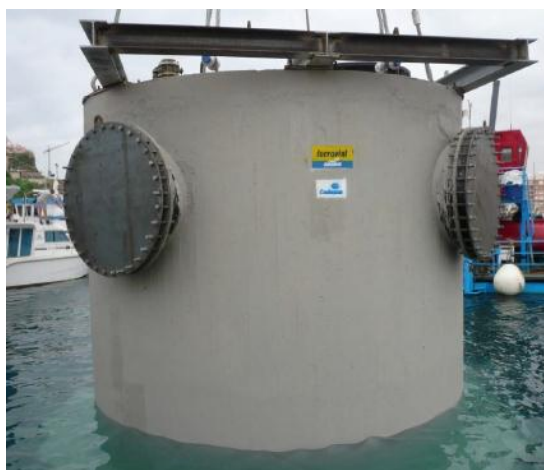
Toma de captación.
