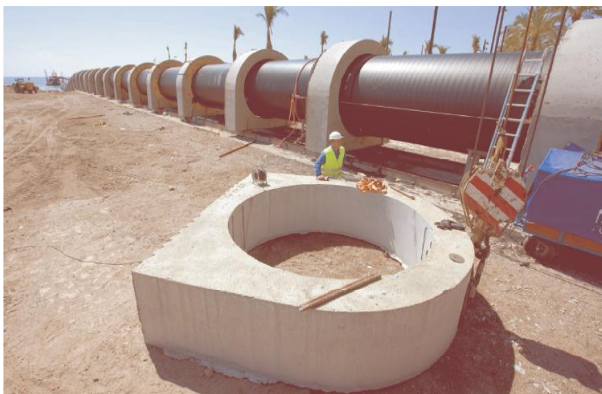
Inmisario de captación.
