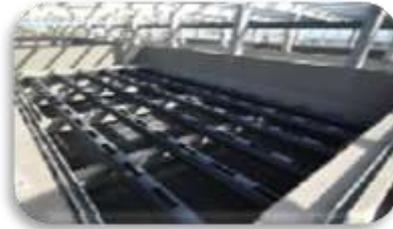
Figura 7.5. Filtros por gravedad usados en la IDAM.
