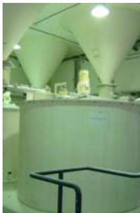
Figura 7.26. Saturadores de cal utilizados en la IDAM.
