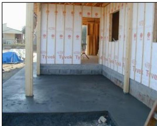
**Figura n°20: Fachada exterior recubierta de material aislante.**
