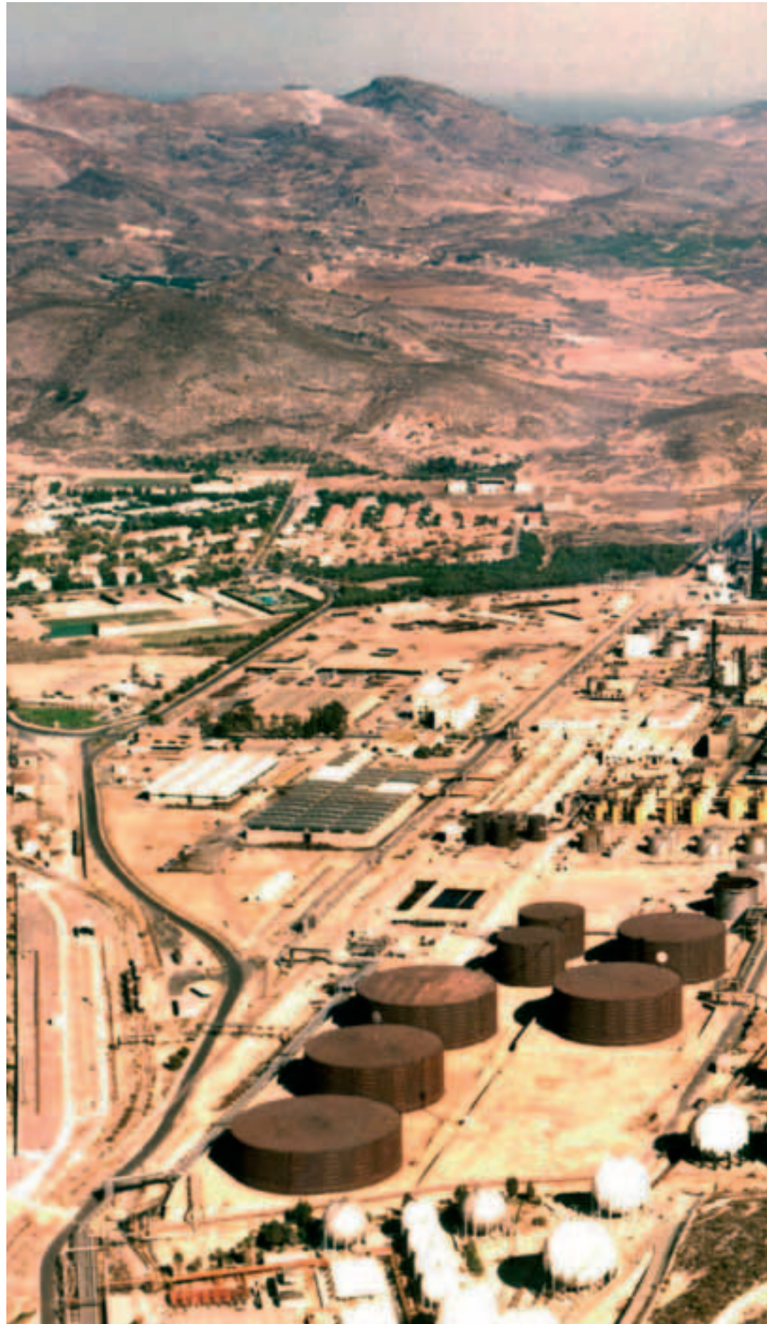
Vista general de las instalaciones de la refinera de petrleo de Escombreras, construida por Repesa e integrada en la Empresa Nacional de Petrleo S.A. (Empetrol) en 1974. Murcia, años ochenta
