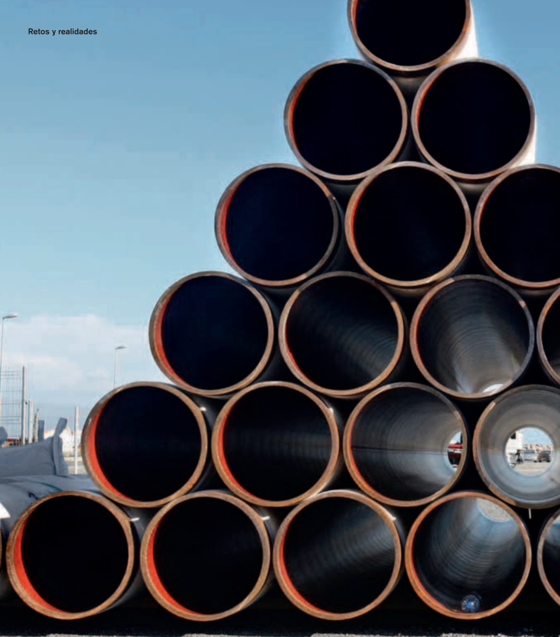
Intercambio eléctrico. Más de 6.000 tuberías llegan al puerto de Almería para la construcción del gasoducto submarino de 210 kilómetros de longitud entre Argelia y España. Almería, 2007
