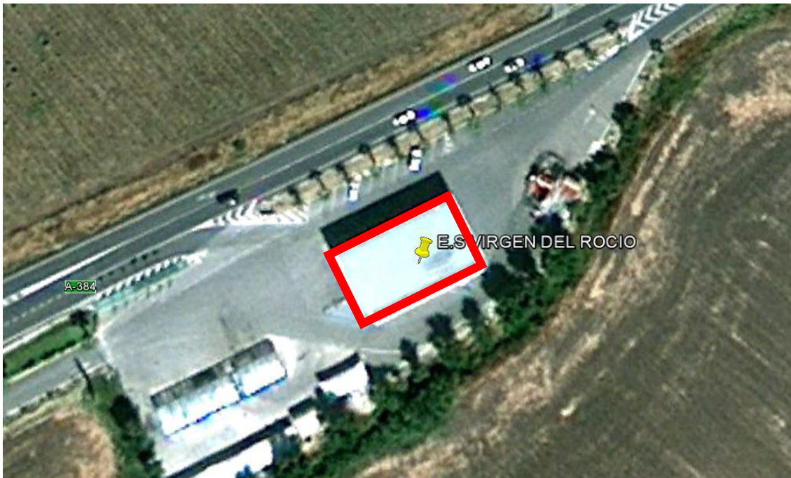
Imagen 3: Cubierta de la estación de servicio.
