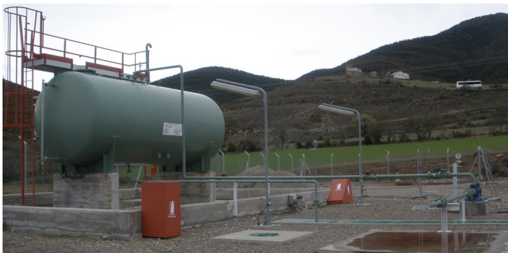
Ilustración 45: Tanque de metanol en Serrablo.
