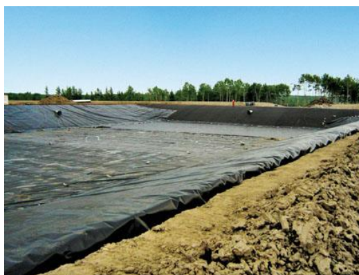
Ilustración 20: Balsa de Lodos.
