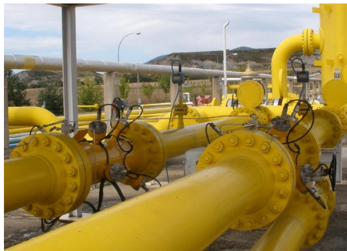
Ilustración 32: Medidores ultrasonido Serrablo.
