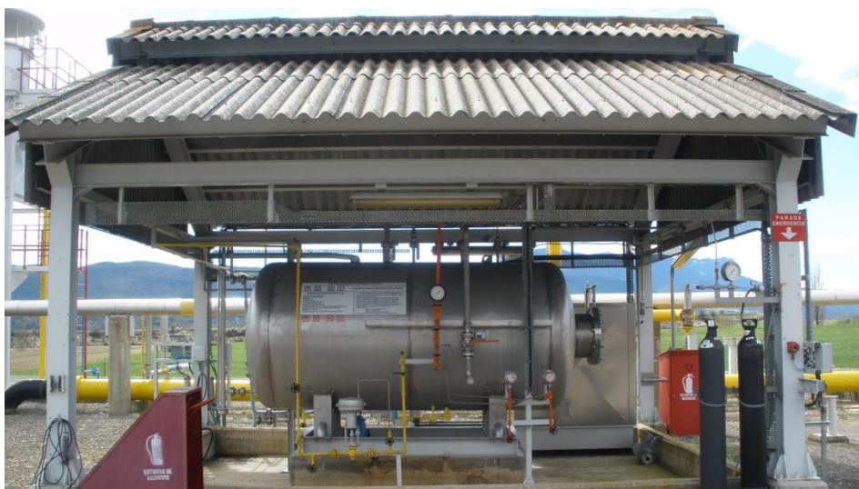
Ilustración 43: Sistema odorización Serrablo.
