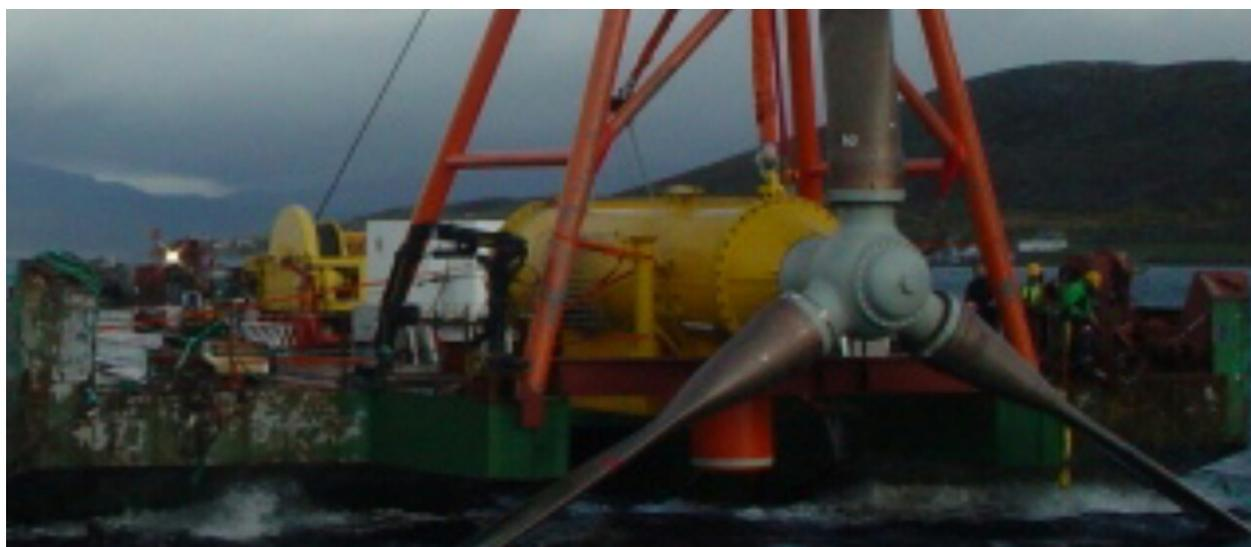
Figura 4.1. Montaje de una Turbina Marina.
