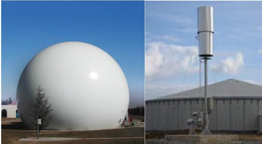
Figura 34. Gasómetro (Prosec) y antorcha
