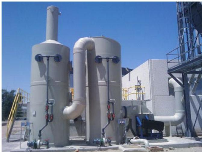
Figura 12. Sistema de desodorización por vía química del fabricante TECOPLAS
