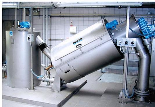
Figura 9. Espesador dinámico tipo Huber
