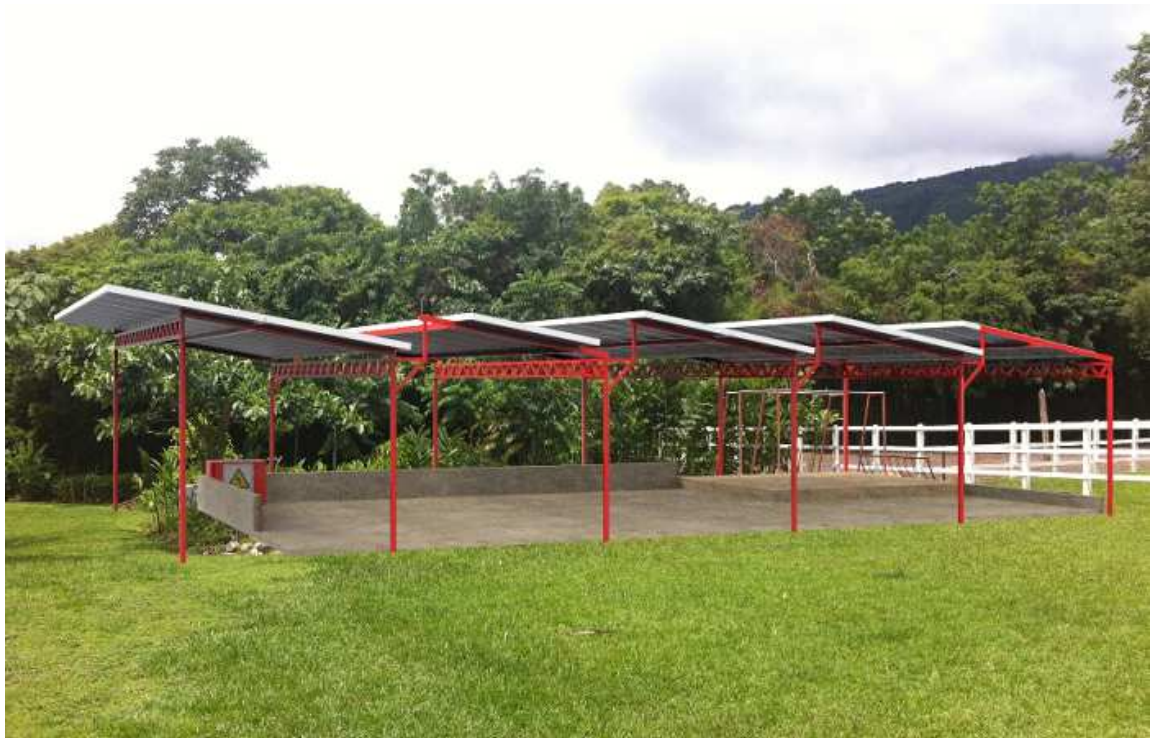
Figura 11. Imágenes de la estructura en el emplazamiento
