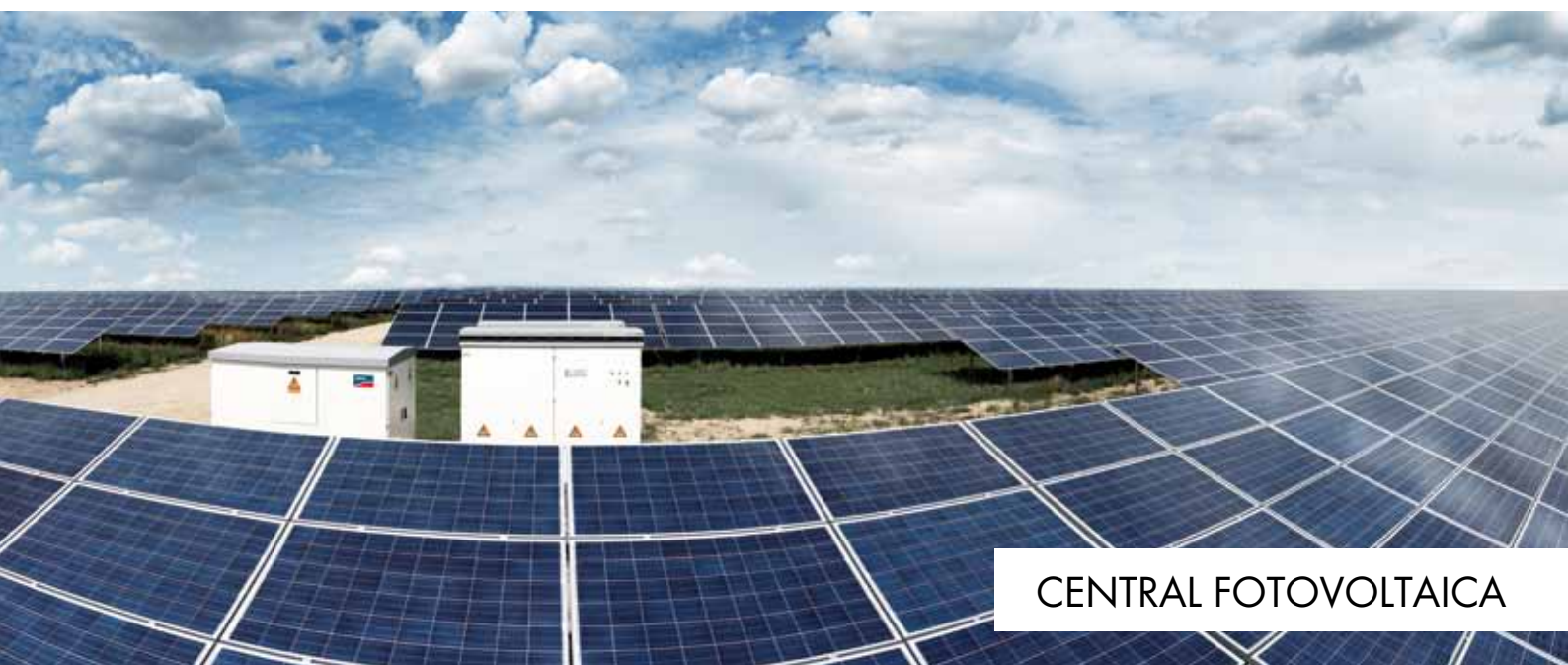
INSTALACIÓN FOTOVOLTAICA INDUSTRIAL
