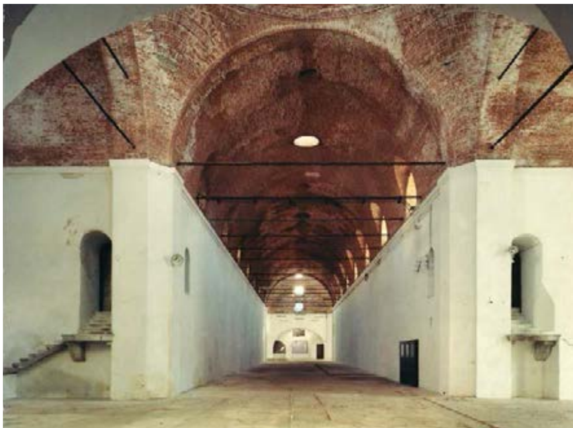
Estado de la nave de hornos antes de las obras.
