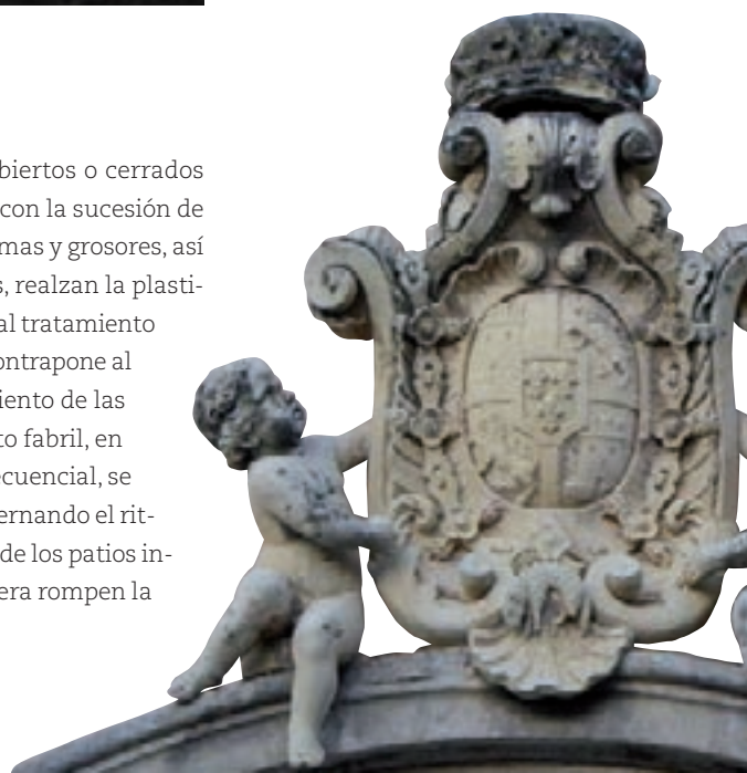
ESCUDO. Detalle de la fachada sur
