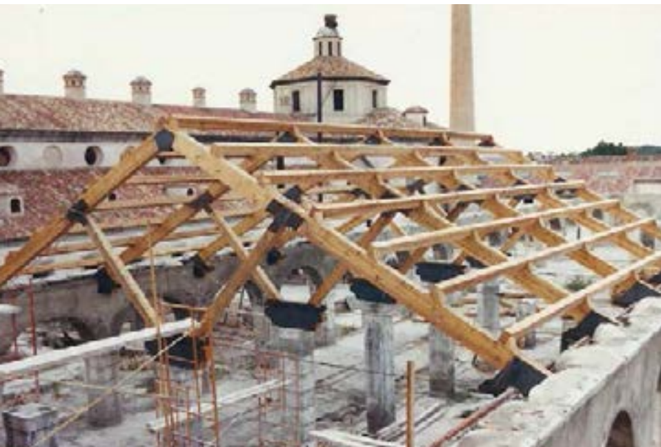
Almacén de madera. Construcción de la cubierta.
