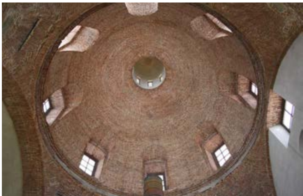
Cúpula de la nave de hornos. Museo Tecnológico del Vidrio. Fundación Centro Nacional del Vidrio
