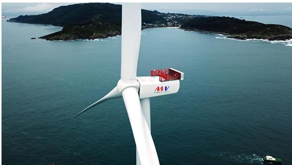
Ilustración 34. Fotografía de un Aerogenerador Vestas V164 - 10 MW
