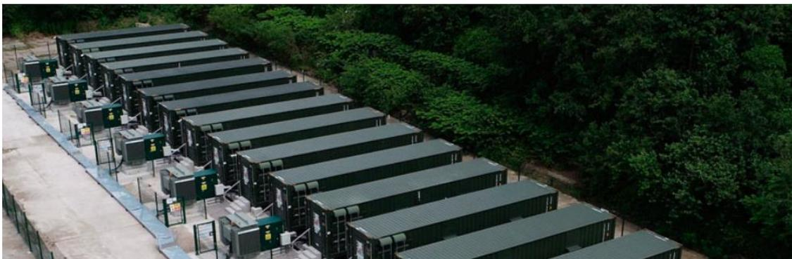
*Ilustración 2.1. Sistema de Baterías de Litio para almacenamiento a gran escala.*
