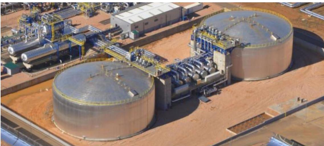
*Ilustración 2.6. Vista aérea de tanques de almacenamiento de sales calientes de una centra termosolar de CCP.*
